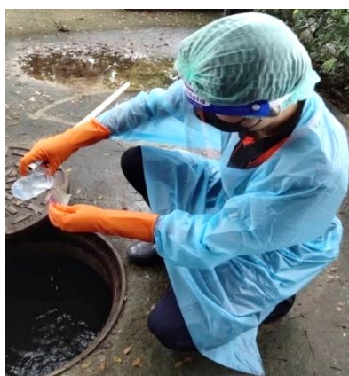
รูปที่ 3.5-3 การเก็บตัวอย่างน้ำเพื่อตรวจสอบประสิทธิภาพระบบบำบัดน้ำเสีย
